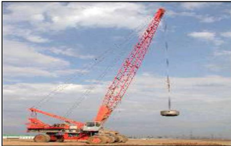
a. Atelier de compactage dynamique (Document Ménard Sol traitement).
