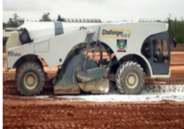
Figure II.9: Chantier de traitement d'un sol à la chaux (France, 2009).
