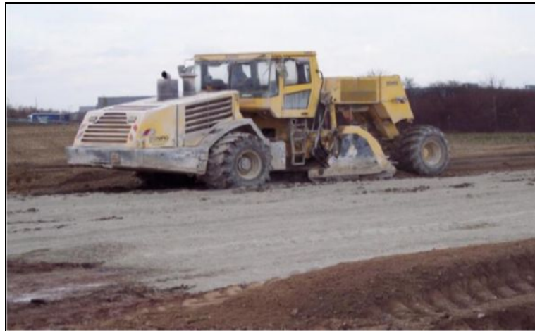
Figure II.8: Chantier de traitement du sol au ciment.
