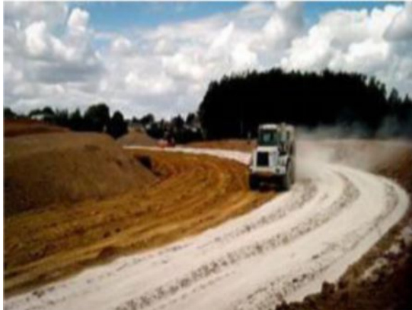
Figure II.9: Chantier de traitement d'un sol à la chaux (France, 2009).
