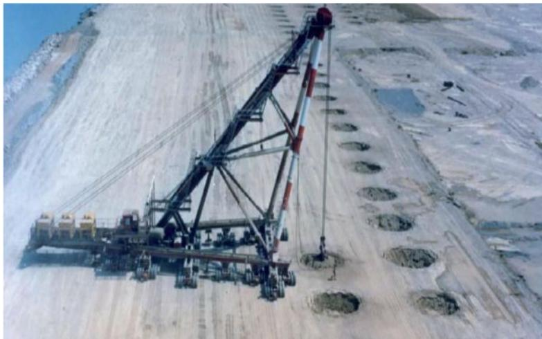
**Figure 3.2:** Chantier d'un compactage dynamique profond (Compactage dynamique à très haute énergie (4000 t.m) aéroport de Nice (1978)
