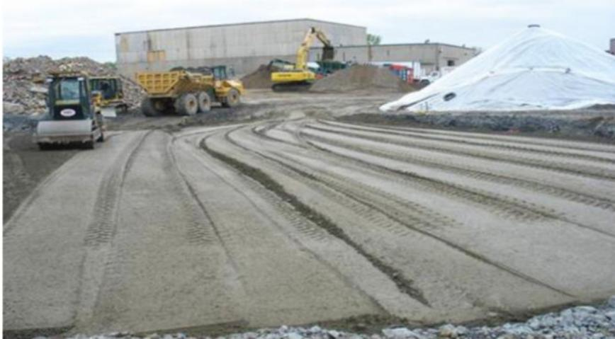
**Figure 3.13:** Chantier de traitement du sol au ciment
