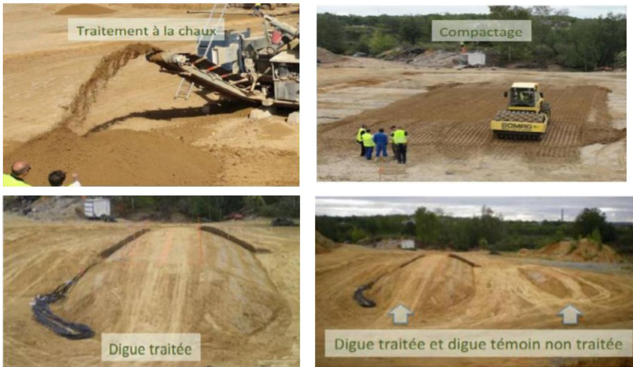
Figure 3.12: Traitement à la chaux (Projet Lhoist-Chanler Pilote)
