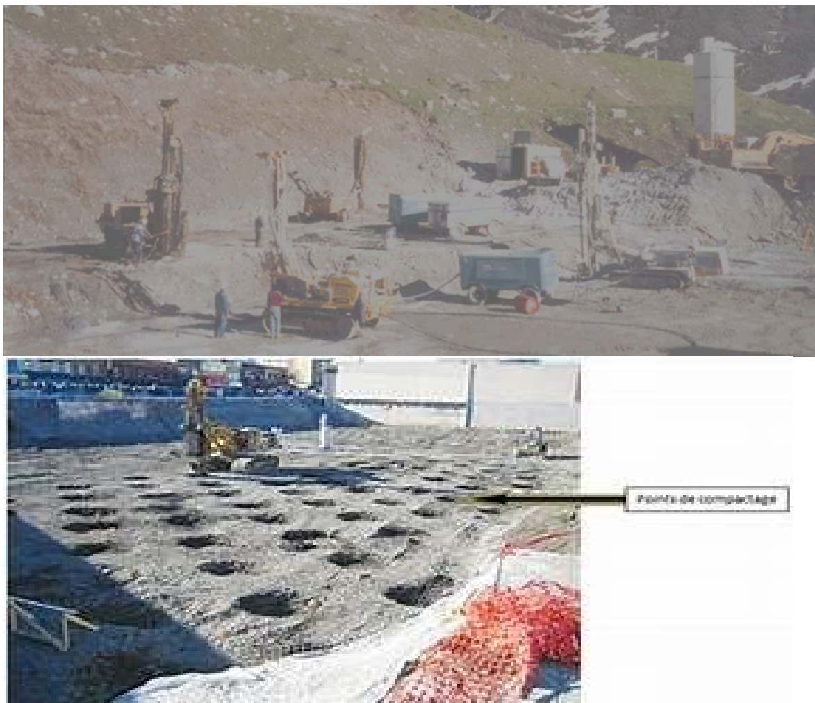
Figure II.24: Amélioration de sol par injection de compactage
