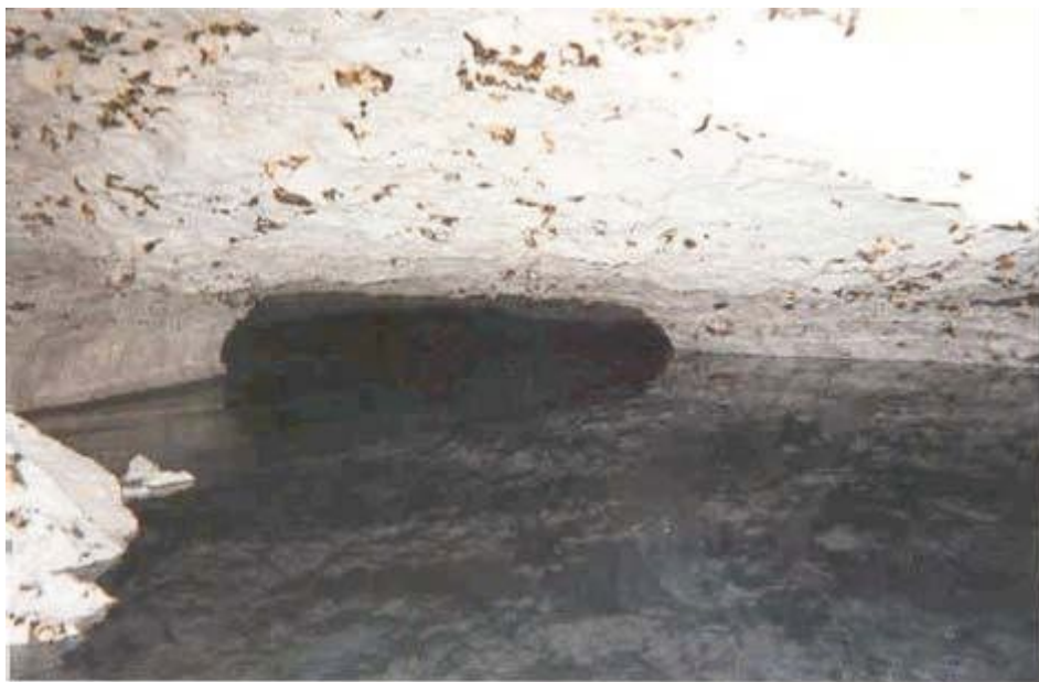
Figure II.19 : Marnière en cours de comblement
