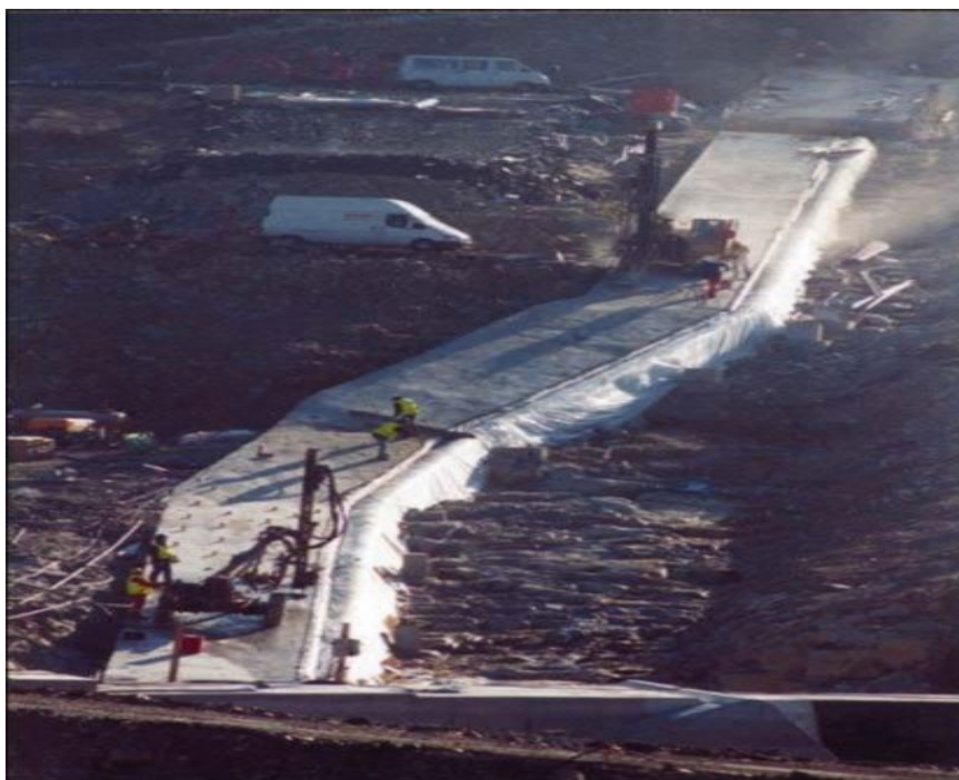
Figure II.23: Linges de forages du voile d'injection
