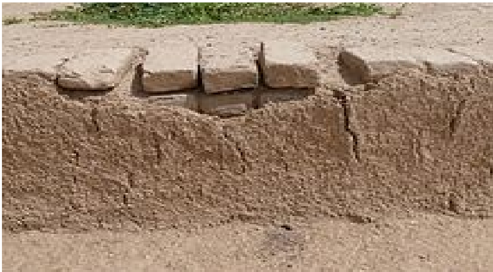
Figure I-02 : Reconstitution archéologique d'un mur. Briques de terre crue et mortier de terre fibré
