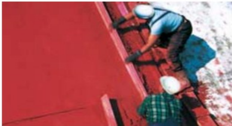
Figure I-08 : Réglage d'une chape (le mortier est ici coloré grâce à des pigments minéraux).
