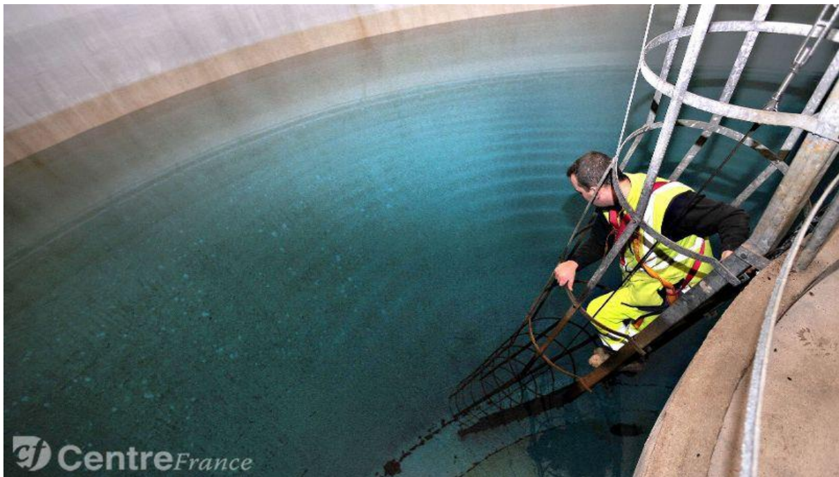
Figure 2.1 nettoyage d'un réservoir.
