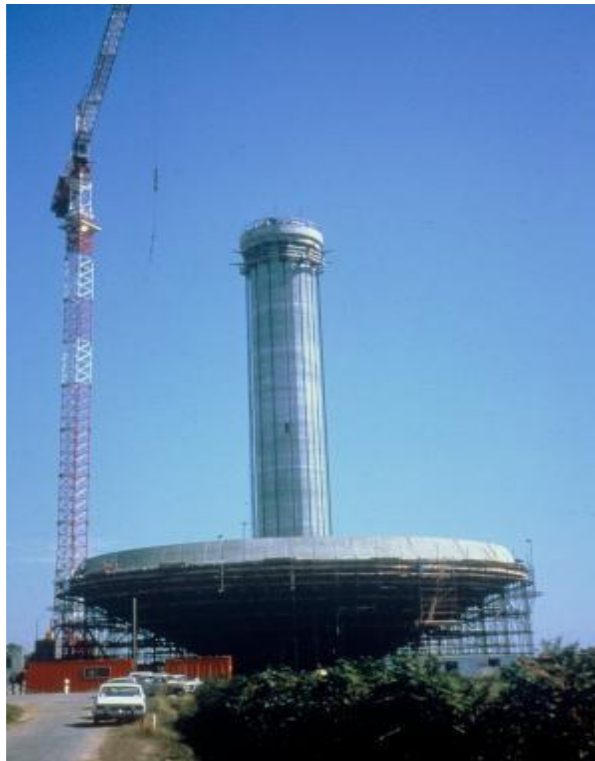
Figure 1.5 Château d'eau avec un échafaudage
