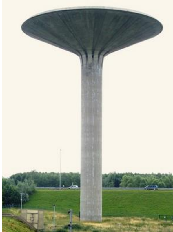
Figure 1.6 château d'eau de Saint Quentin
