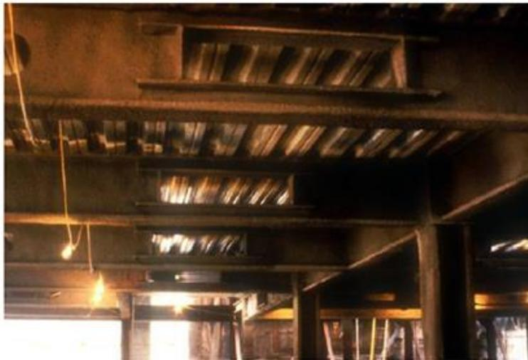
**Figure 2. 1.** Photographie des poutres ajourées renforcées
