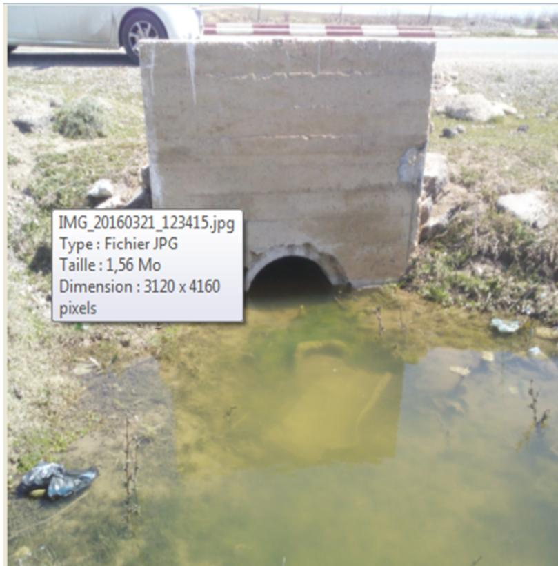
**Photo VI.1 : Ouvrage d'Assainissement en bon état nécessitant un curage.**
