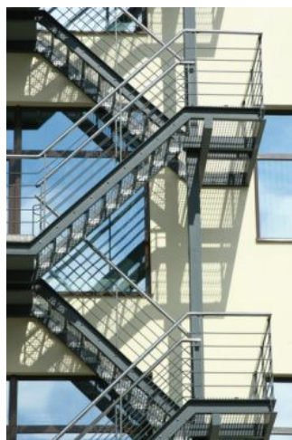
Figure V- 10 : modèle d'escalier de secours
