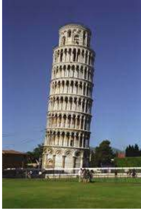
Figure 1.5 --Inclinaison de la tour de Pise (Italie) due au tassement de la fondation.
