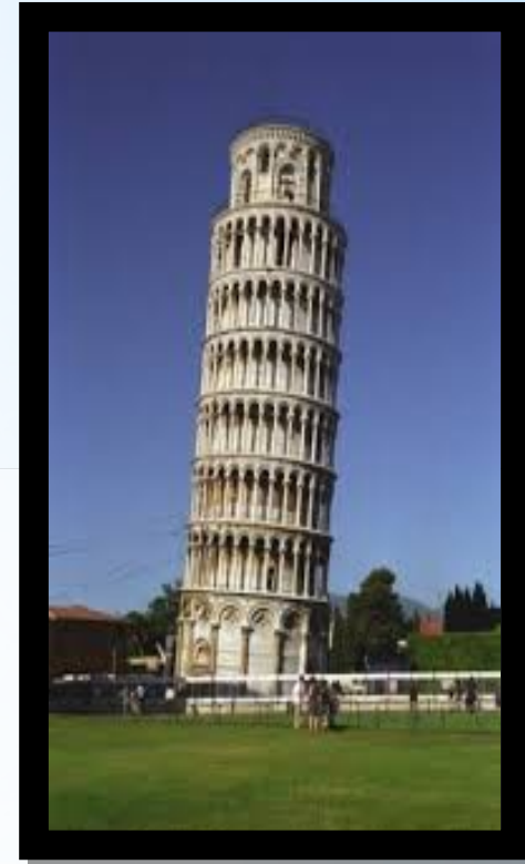
Inclinaison de la tour de Pize ( tassement différentiel)
