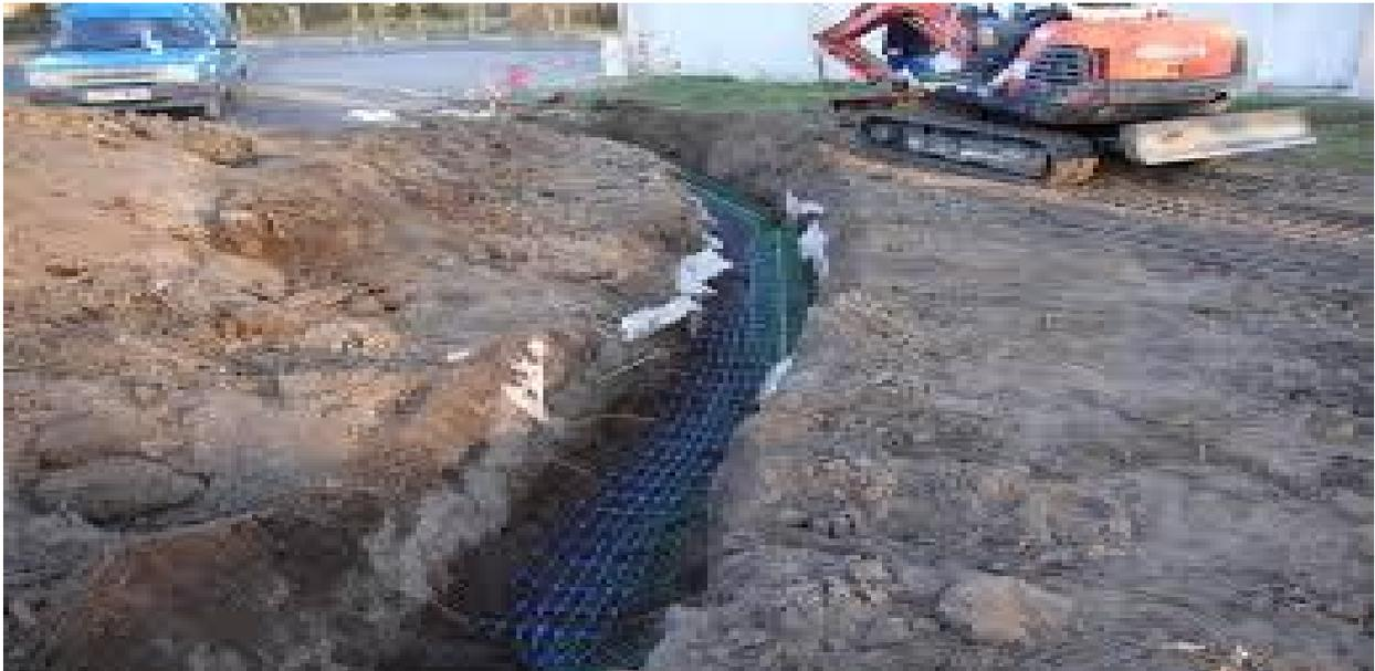
**Photo (III.1) : Ouverture de tranchée de faible largeur en milieu urbain assurant un compactage de qualité**
