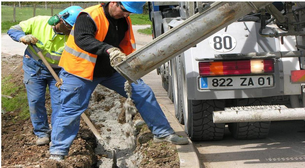
**Photo (III.2) : Remplissage de tranchée avec un remblai autocompactant par simple déversement**
