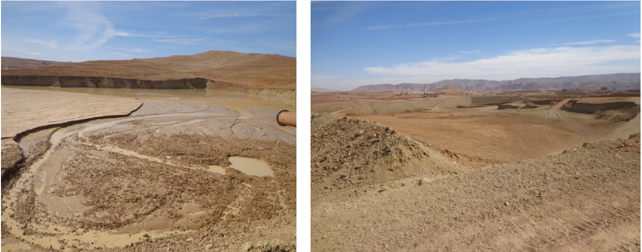
Photo I.2.3: Les Bassins de décantations des sédiments dragués du barrage Bouhanifia avant et après l'opération de dragage
