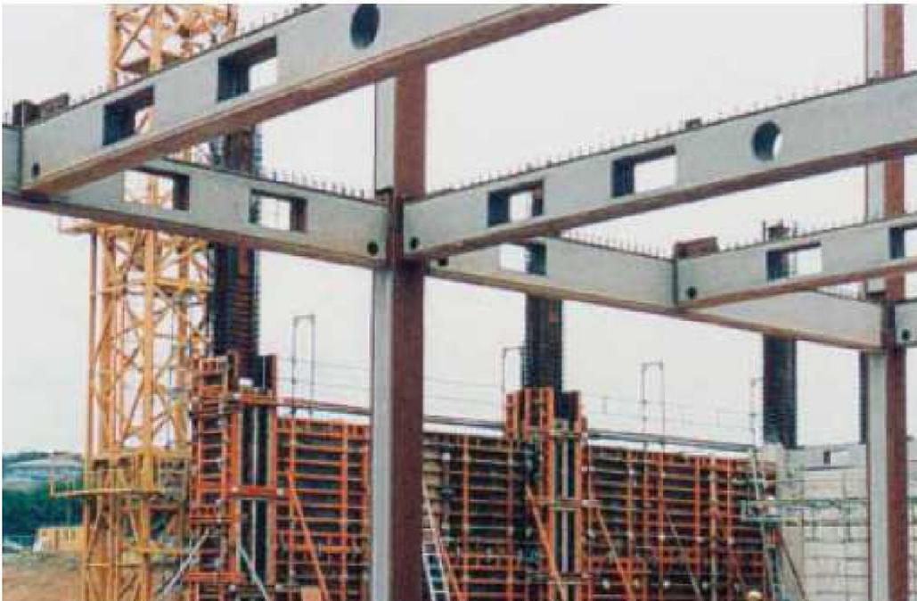
Fig.1.2 : Poutres reconstituées munies d'ouvertures isolées de formes variées.
