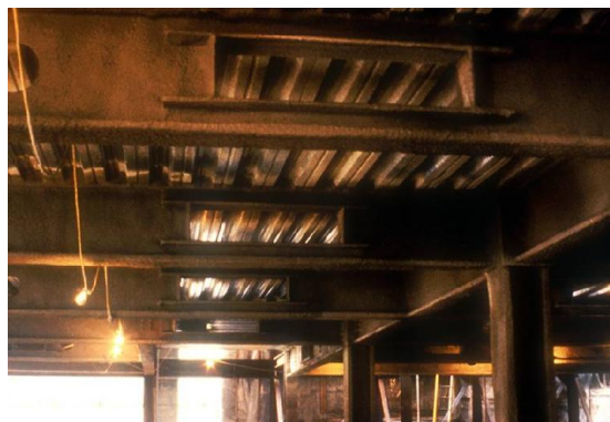
Fig. 2 : photographie des poutres ajourées renforcées.
