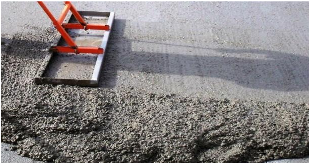
Photo (I.4) : Béton frais
