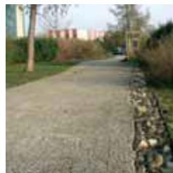
Cheminement piéton bordé d'une tranchée d'infiltration
