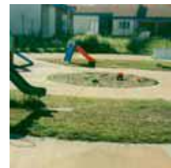
Aire de jeux avec puits d'infiltration central
