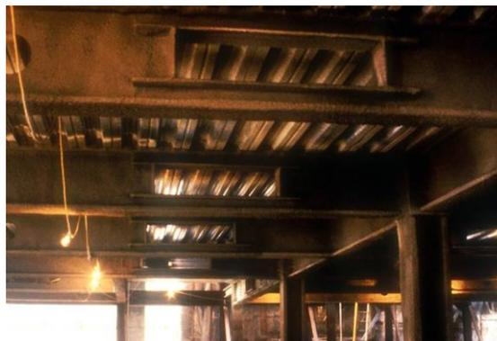
**Fig. 2 photographie des poutres ajourées renforcées .**
