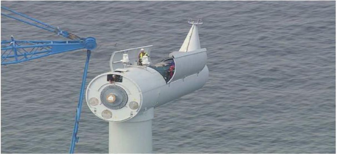
Figure.1.5 : Vue aérienne de la nacelle pendant l'assemblage d'une turbine éolienne.
