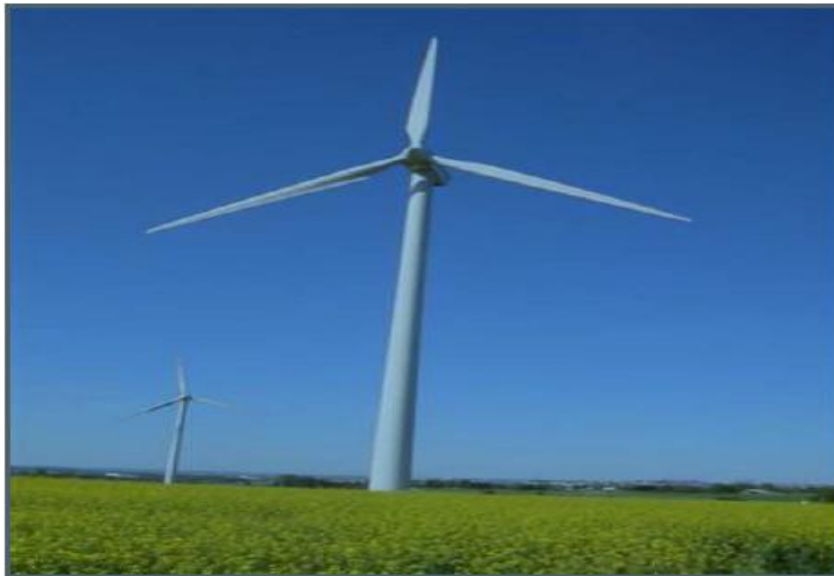
Figure. I. 10. Aérogénérateur à axe horizontal
