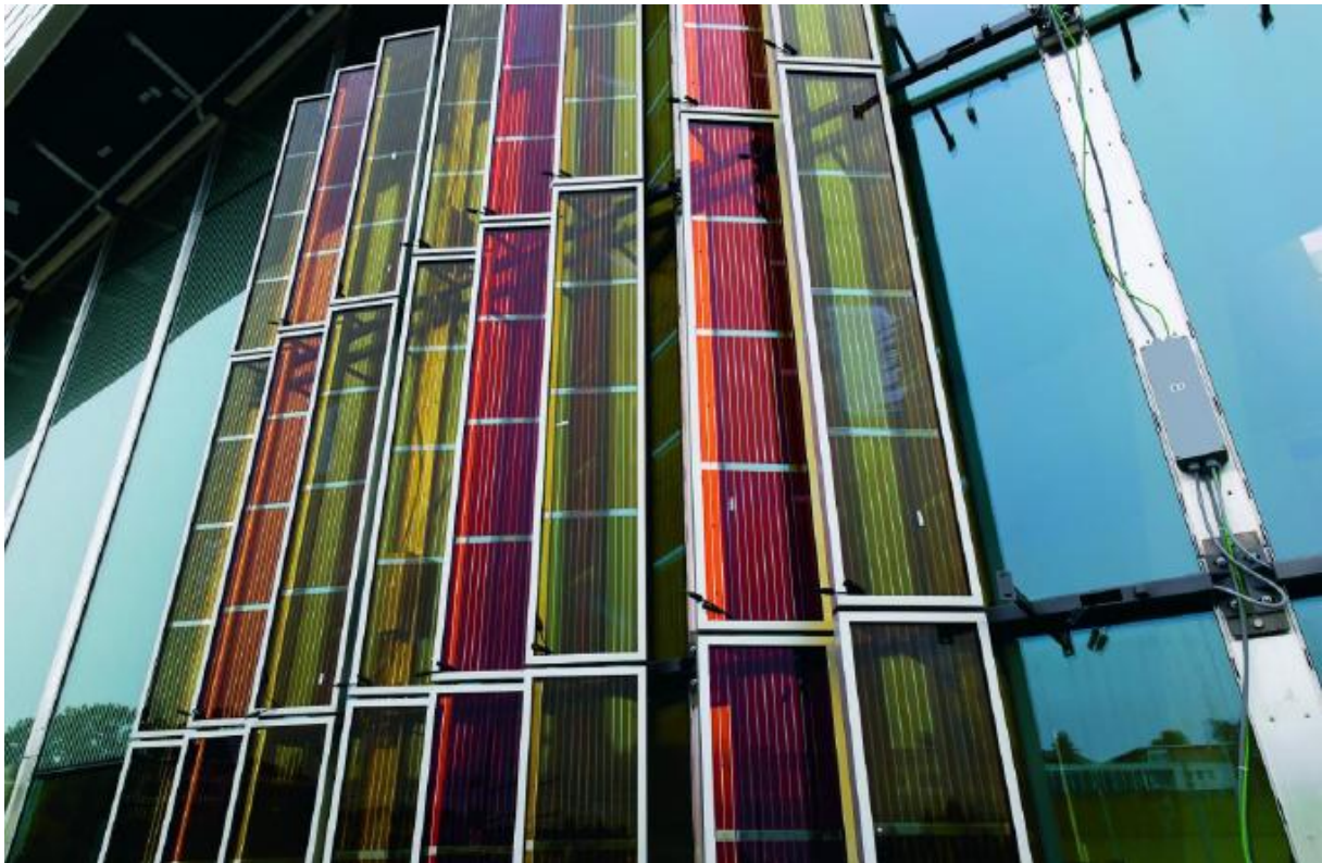
Figure I.7: Les cellules nanocristallines à colorant [14]
