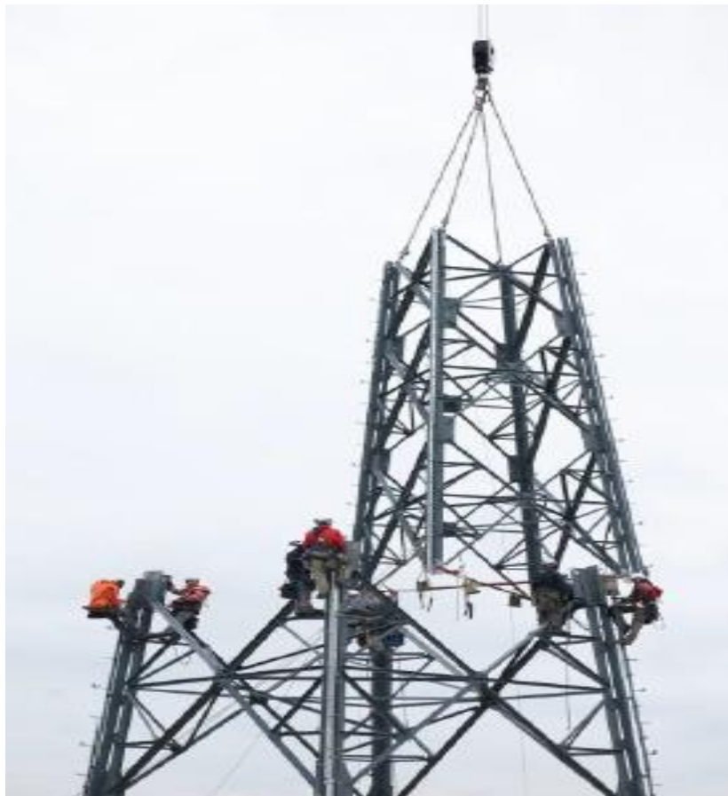
Figure IV.9 Montage à la grue[8]
