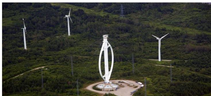
Figure I. 4 éolienne à axe vertical & éolienne à axe horizontal
