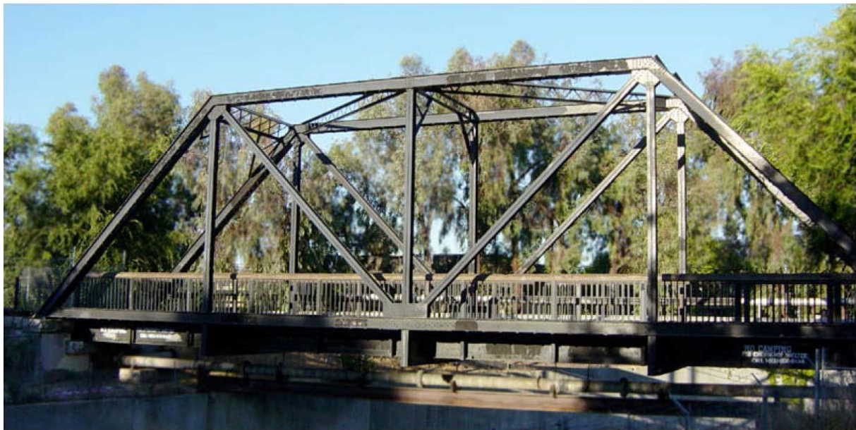
Photo I 1: pont en treillis
