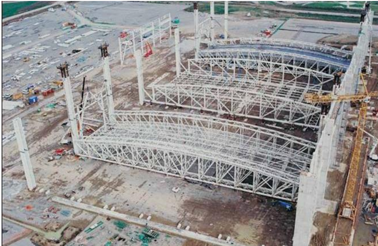
Photo I 2: poutre Treillis en N (ou treillis Pratt)
