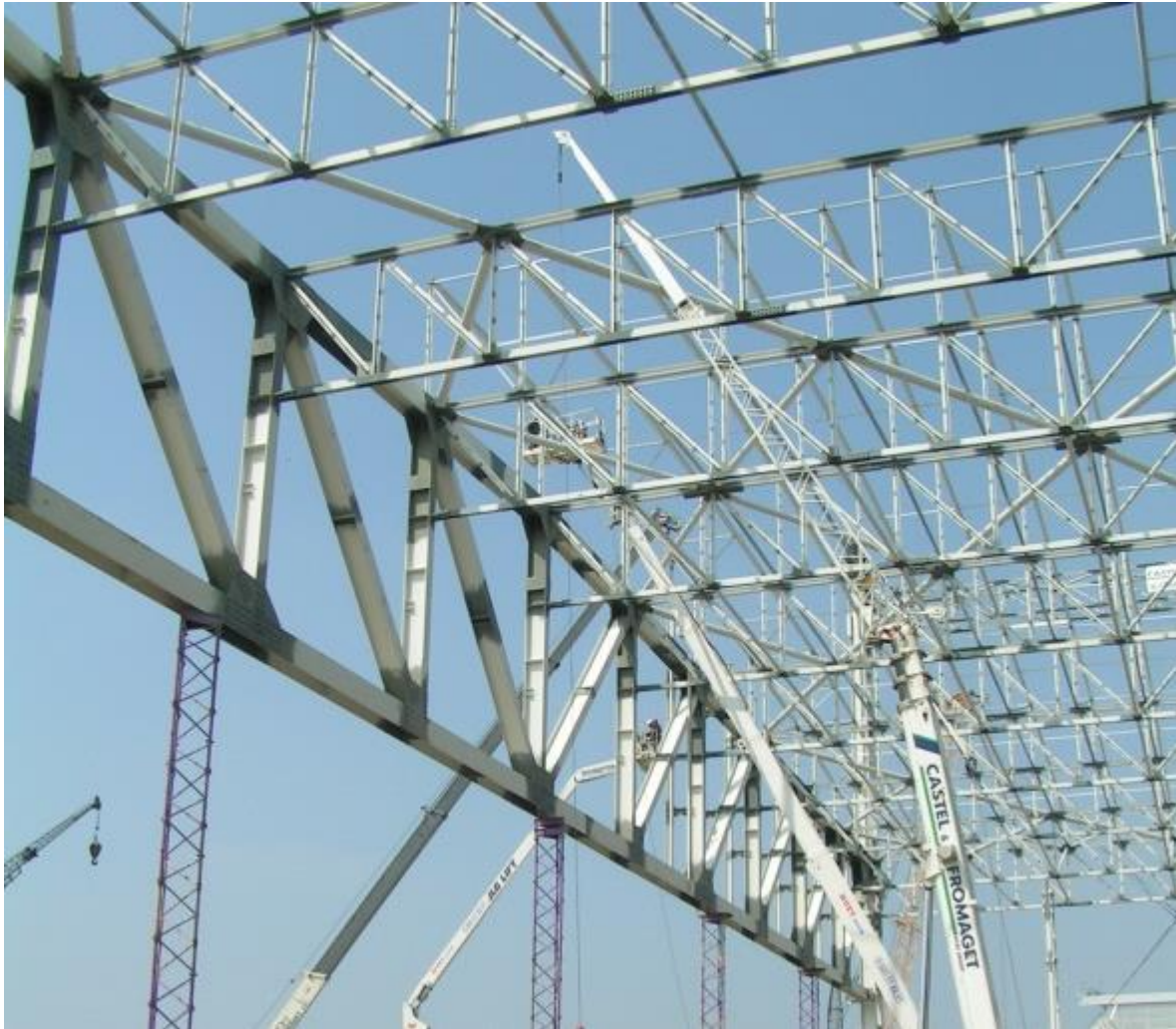
Photo I 3: poutre treillis de type Warren.
