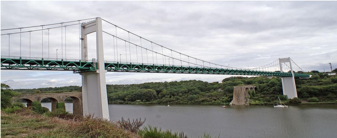
Figure .7 : Pont suspendu
