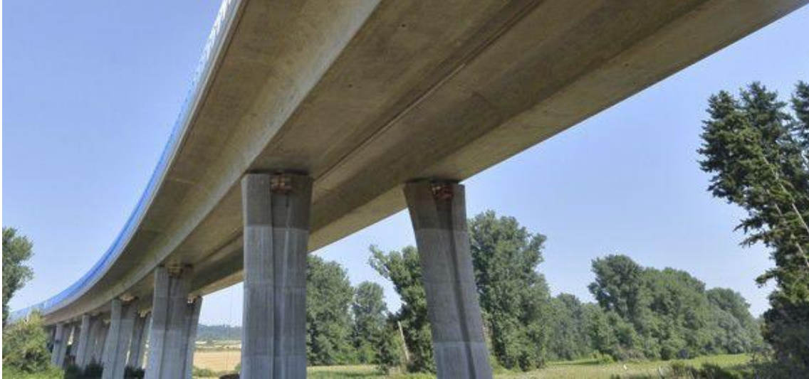
Figure .5 : Pont en béton armé
