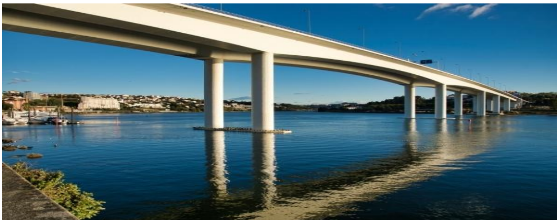
Figure .6 : Pont en Béton précontraint
