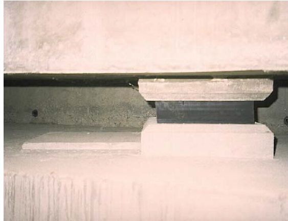
Figure VII. 3 : Appareil d'appui en élastomère fretté.
