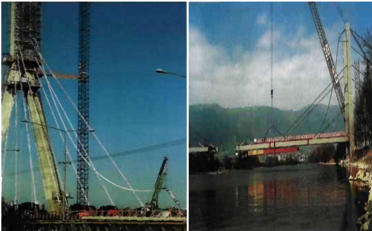
Photos X.2 et 3: Mise en place de haubans préfabriqués
