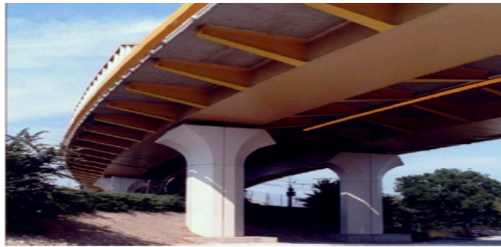
Photo II.1: Exemple de pont mixte à poutres multiples
