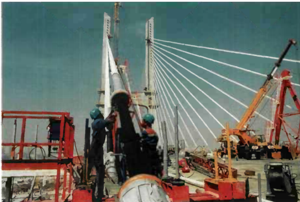
Photo X.4: Enfilage toron par toron d'un hauban du pont
