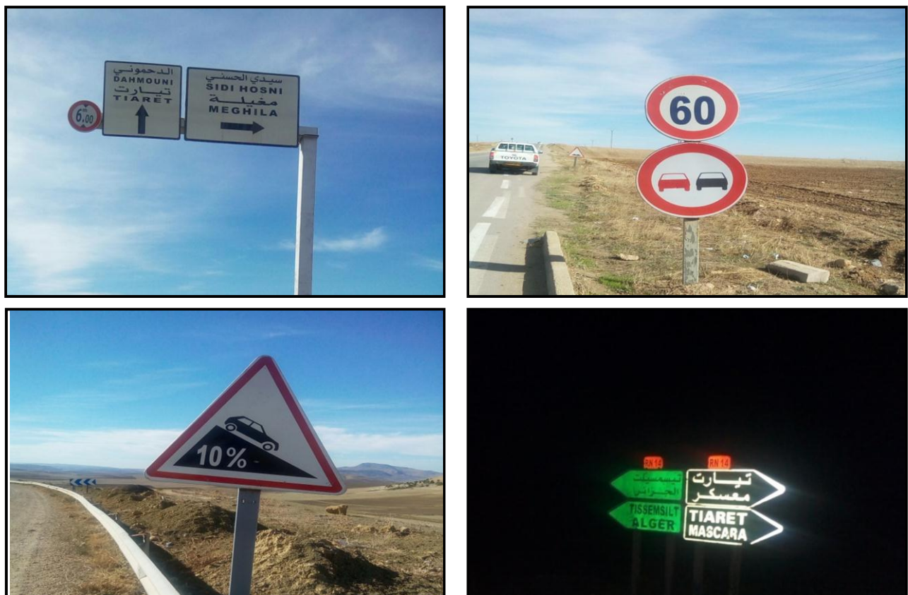
Fig.(III.21) Panneaux de la signalisation verticale en bon état.
