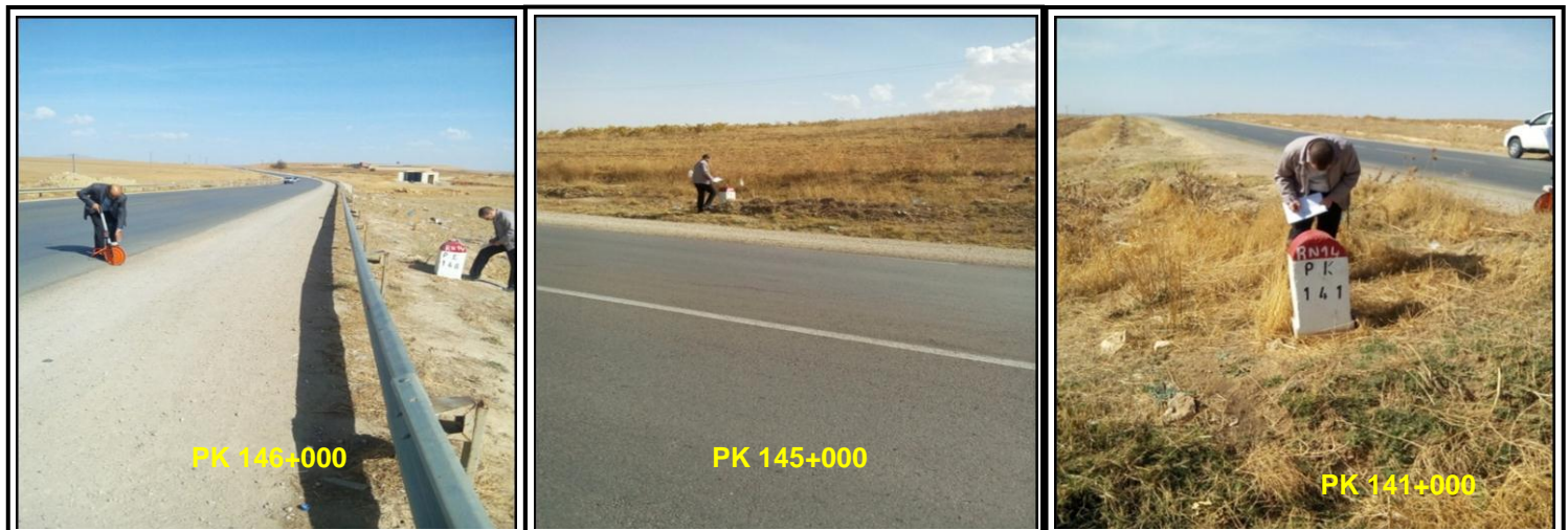
Fig.(III.12) Mesures de la géométrie de la chaussée(PK).
