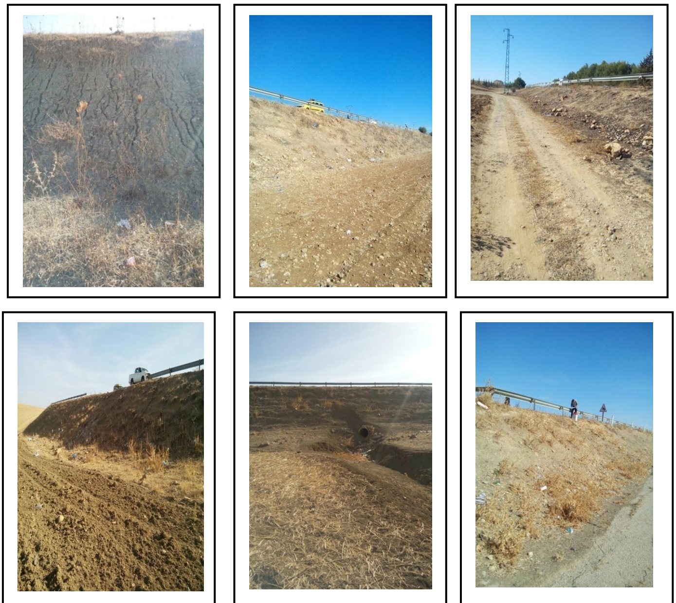
Fig.(III.18) Les zones de remblai sur long du tracé.
