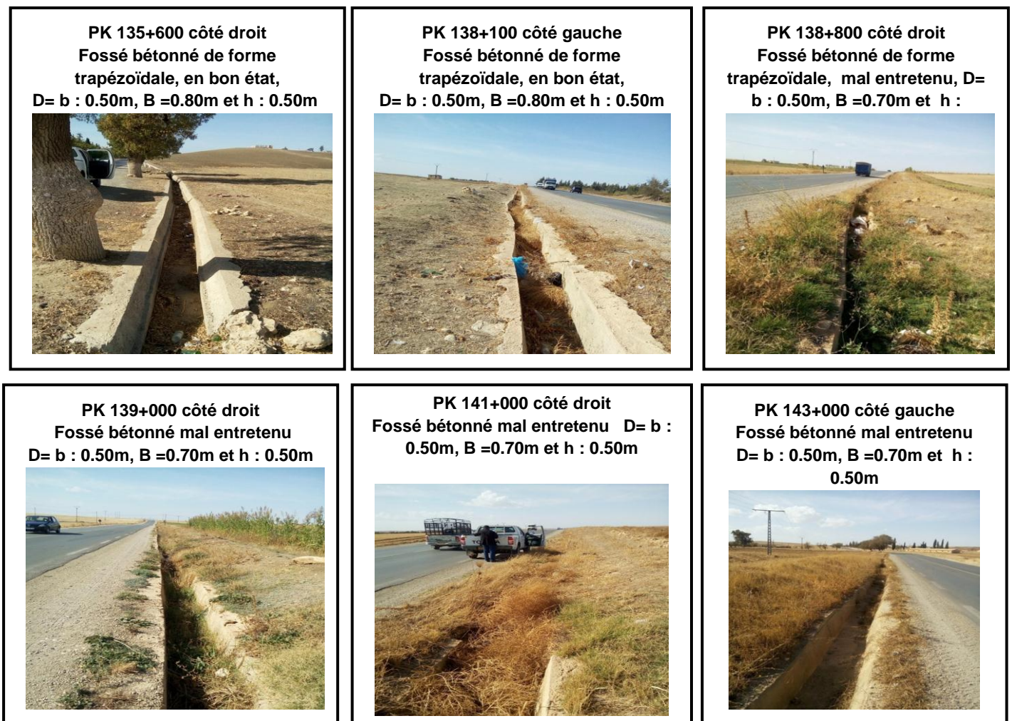
Fig.(III.17) Les photos fossés bétonnés du tracé investigué.
