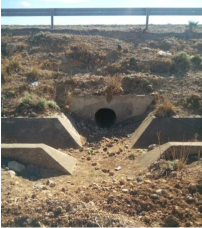
Ouvrage buse pk 119+050 côté droit, \varnothing 600 , bon état
