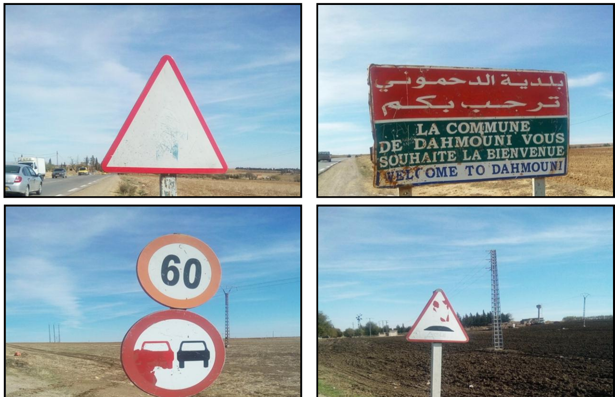
Fig.(III.23) Panneaux de la signalisation verticale en état dégradé.
