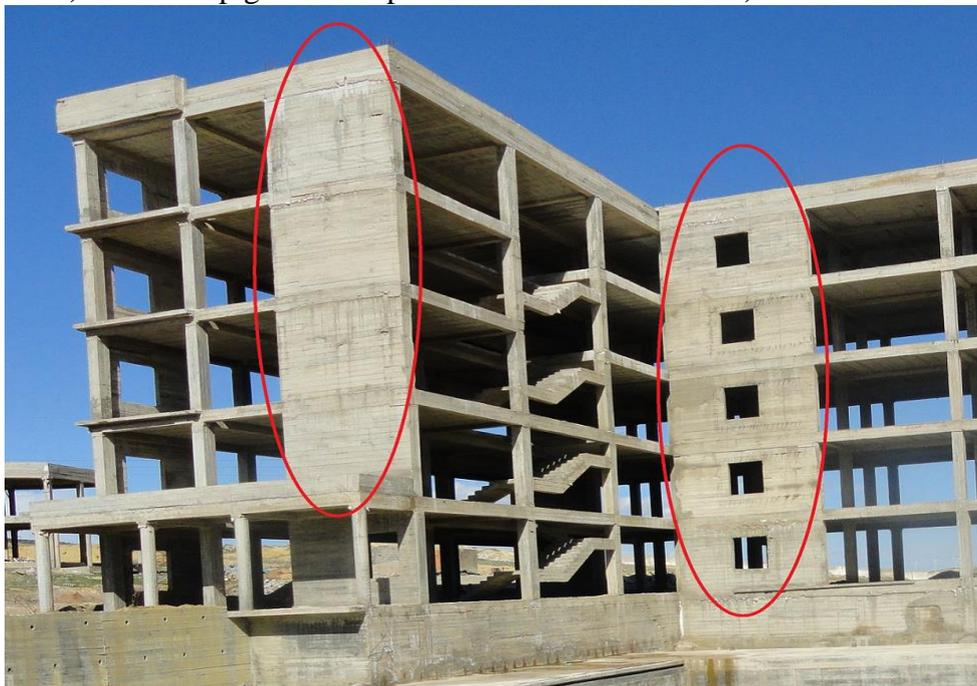
**Figure I.10 :** Bâtiment avec murs voiles (CFCL Tiaret).
