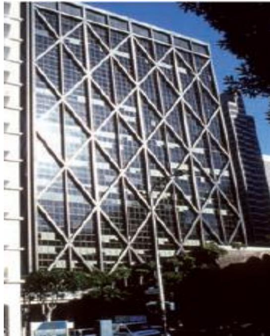
**Figure I.5 :** Diagonales courant sur plusieurs niveaux. Elles doivent être fixées à tous les planchers.
