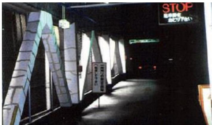
**Figure I.3:** Palées de stabilité courant sur plusieurs travées, ce qui permet d'obtenir une largeur importante.
