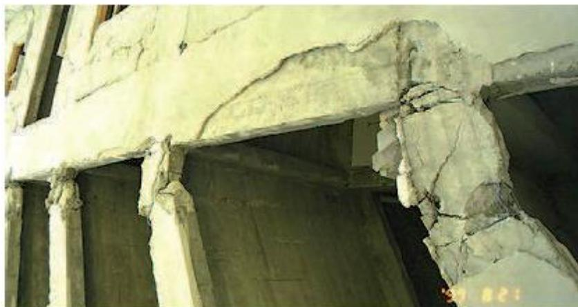
**Figure I.1:** Contreventement longitudinal insuffisant.
