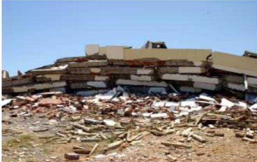
**Figure I.7:** Effondrement total des constructions non ou mal contreventées (Séisme de Boumerdes 2003). [4]
