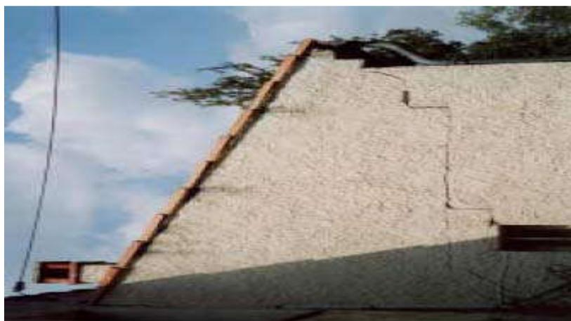
Figure 0.5: fissures au niveau d'une structure de génie civil
