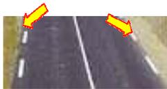
**Ligne de rive** : trait 3m, intervalle 3,5m Sépare la chaussée de l'accotement, peut être franchie pour s'arrêter ou stationner. Dans les sens uniques, la ligne de rive à gauche est continue.
