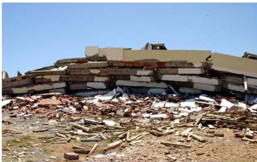
Photo III.2 Séisme Boumerdès 2003- rapport préliminaire V.DAVIDOVIDCI.
