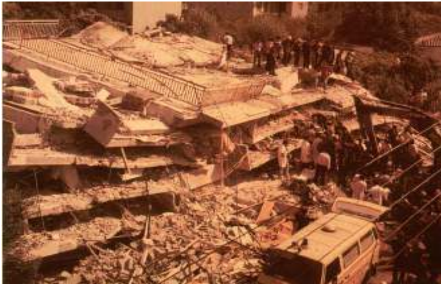
Photo III.1 Séisme de Kalamata [11]
