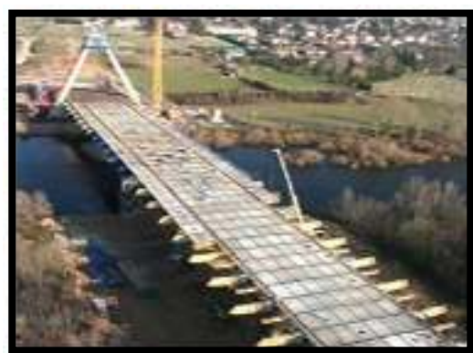
Ouvrages d'arts ponts (tabliers)
