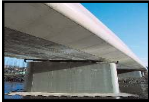
Ouvrages d'arts ponts
