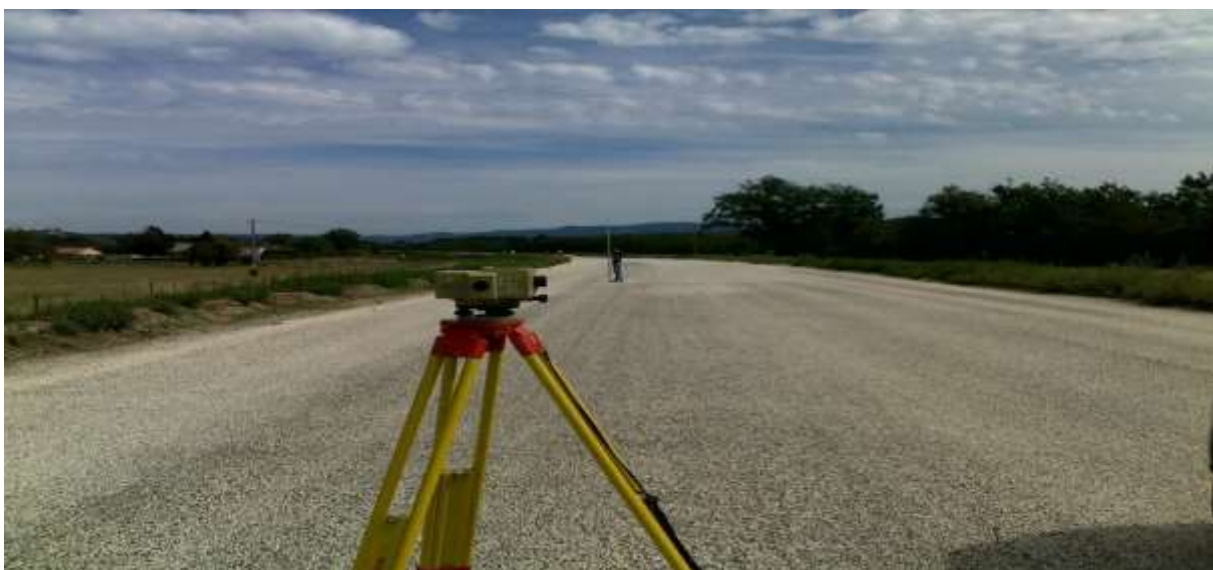
Figure VI. 1: Piquetage et nivellement d'un point
