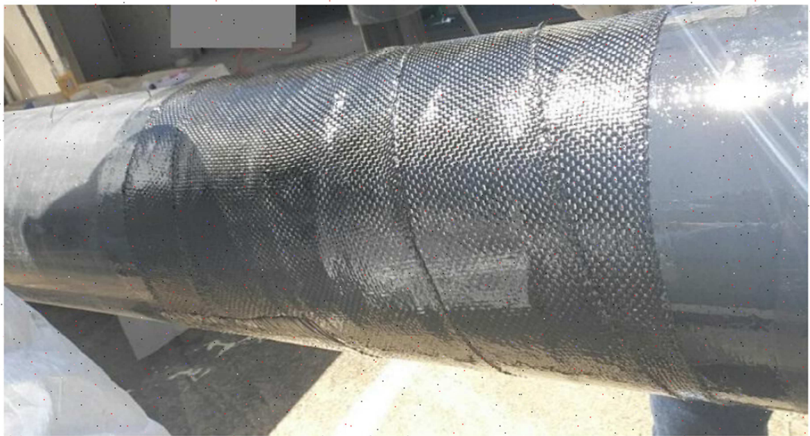
Figure II.3.3 Réparation d'un pipe avec patch en composite.
