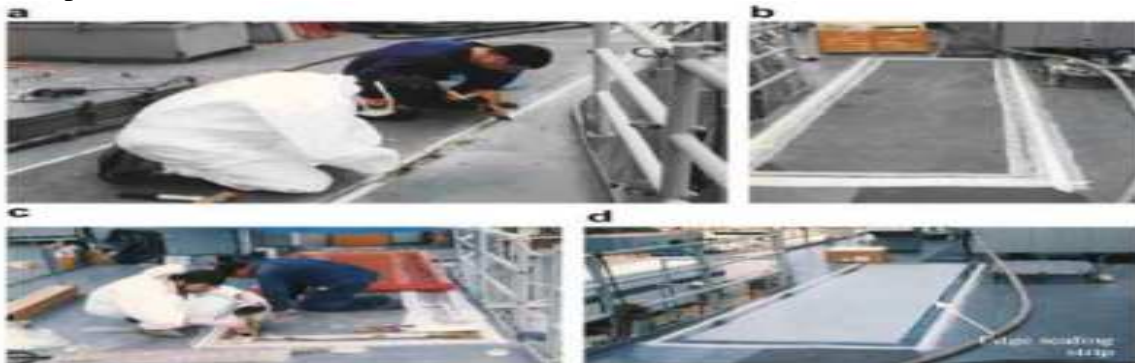
Figure II.3.1. : Réparation des bordages en aluminium par patchs composites.
