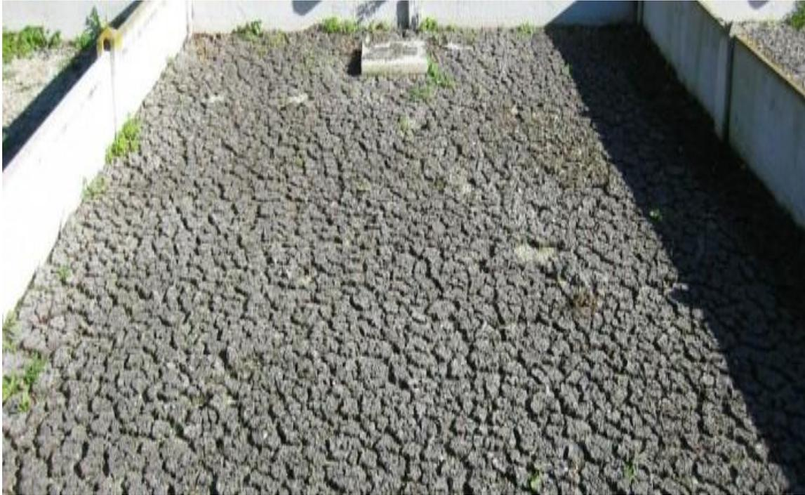
*Figure N°07: lits de séchage des boues primaires et secondaires de la STEP
