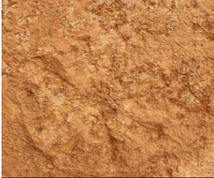
الصورة رقم 05: شكل لزهرة سداسية بالواجهة الجنوبية
