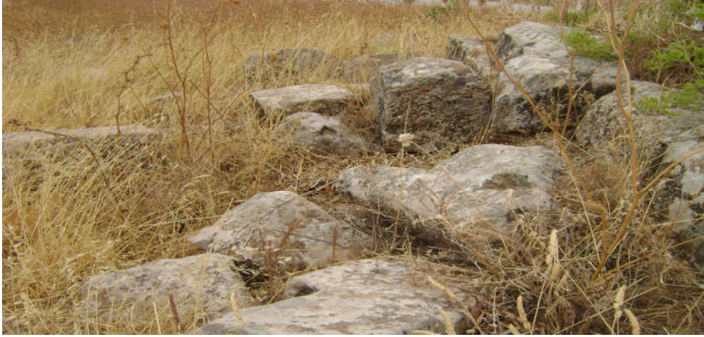
الصورة 07: سقوط اغلب حجارة الضريح
